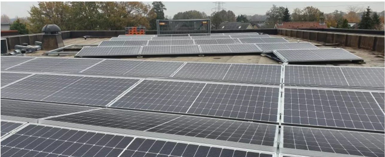
Het dak van ons kantoorpand is in 2021 volledig "vol gelegd" met zonnepanelen
