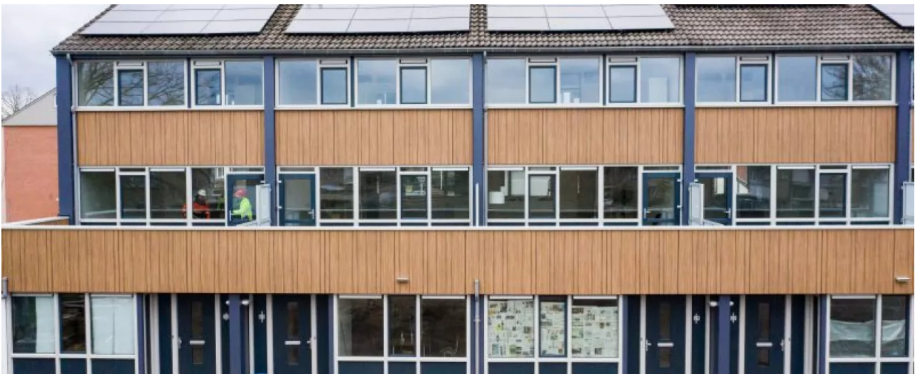
Renovatie aan Ruisvoornstraat/Zeeltstraat
